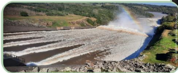
Barragem da Usina Hidrelétrica Passo Real - Salto do Jacuí (R12)
